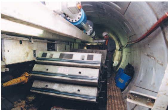
Für Kabeltrassen müssen vielerorts Tunnelanlagen gebaut werden.
