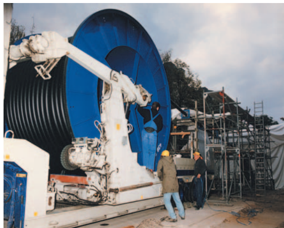
Kabelanlagen werden mit hohem finanziellen und maschinellen Aufwand errichtet.
